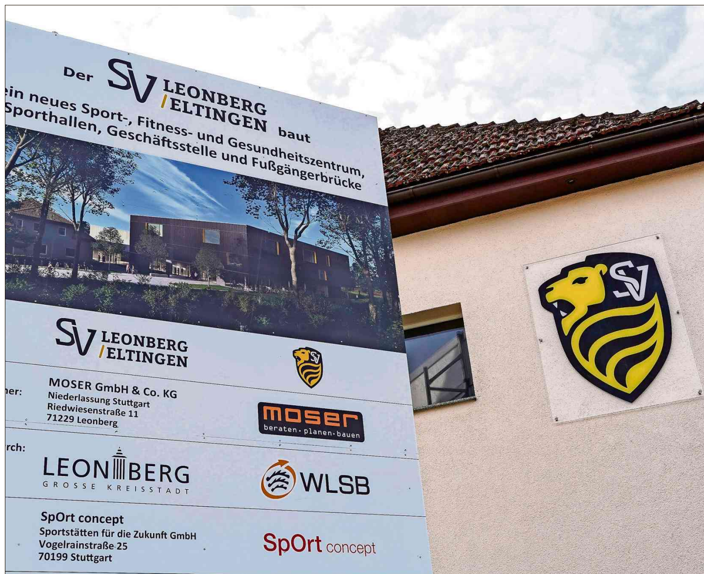
An der Brückenbachstraße wird gebaut. Hier entsteht das neue Vereinszentrum des SV.
