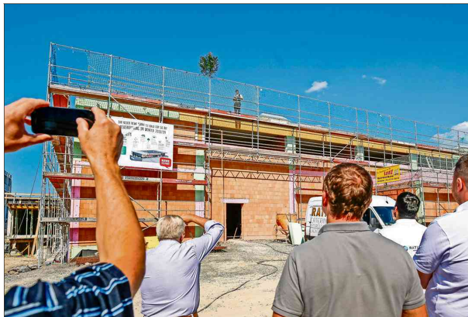
Der Rohbau des neuen Rewe-Marktes ist fertiggestellt.
