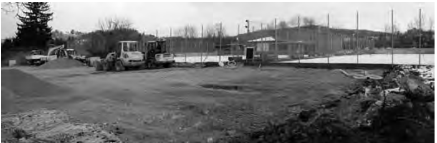
Baustelle des Platz 6 in Eltingen
